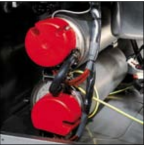
AISI 316 roestvrijstalen boilers, volledig geïsoleerd om warmteverlies te minimaliseren.
