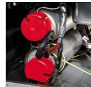
AISI 316 roestvrijstalen boilers, volledig geïsoleerd om warmteverlies te minimaliseren.
